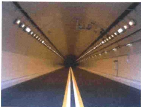
图 17-5 公路客运站车行通道照明示例
