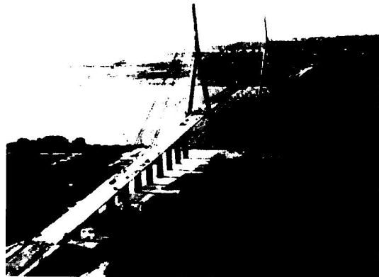
图 1.5 法国的 Pont de Normandie 拉索桥主跨 856m。
