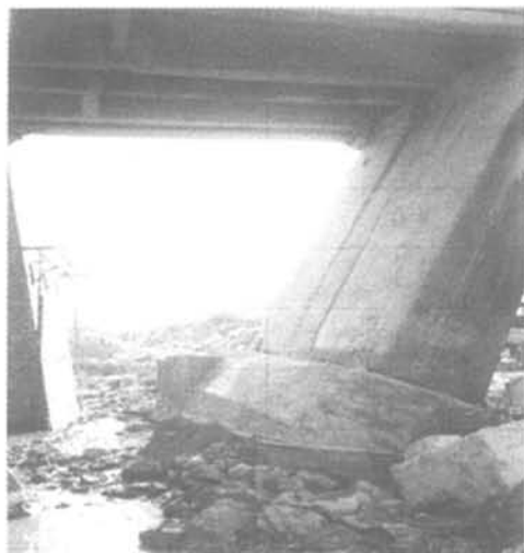
图 1.5 桥梁基础整体翻转
