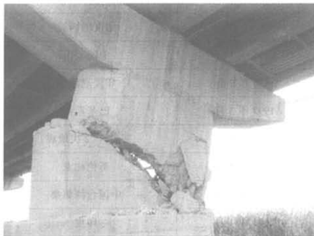
图 1.6 桥墩斜裂缝
