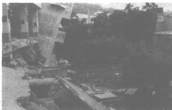
图 1.12 地基隆起导致建筑物破坏
