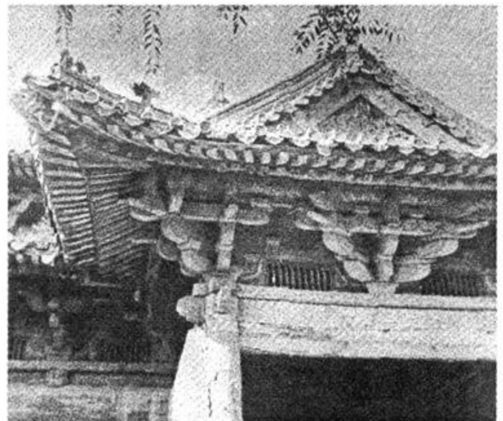
图4 河北正定隆兴寺摩尼殿抱厦一角
