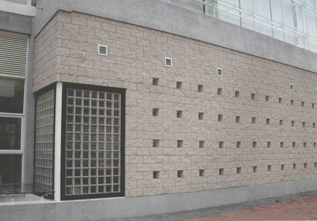
图4-4 深圳万科中心砌块外墙
