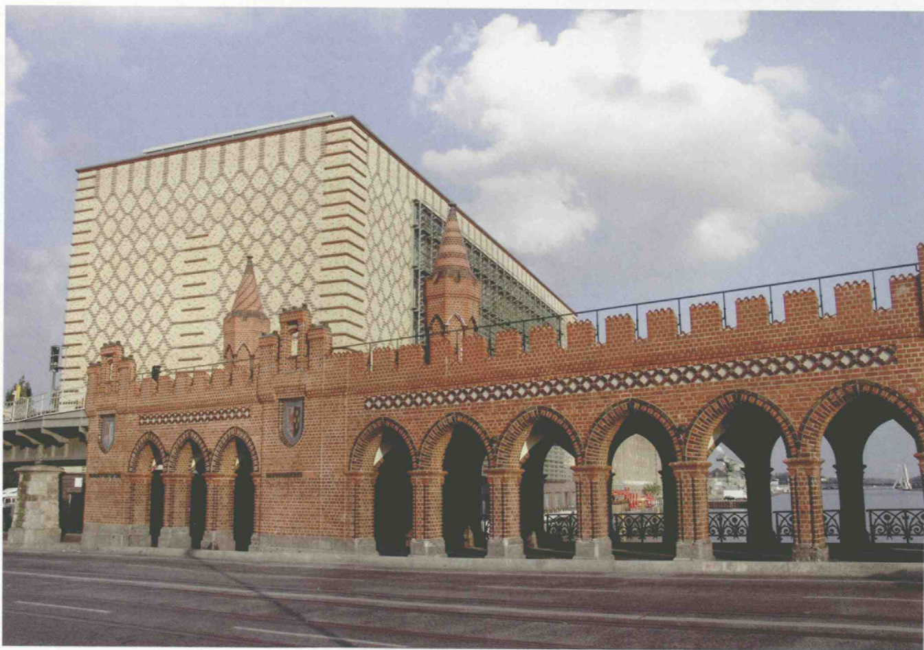
图4-3 传统建筑中常见的砖墙
