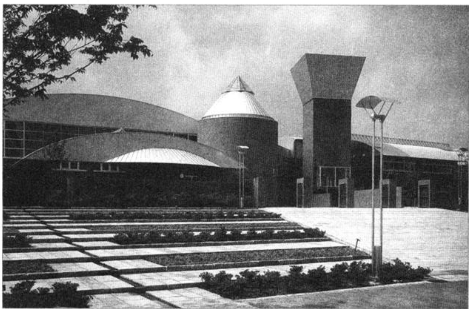
◀ (图4-0-3) 日本印西市立原小学
