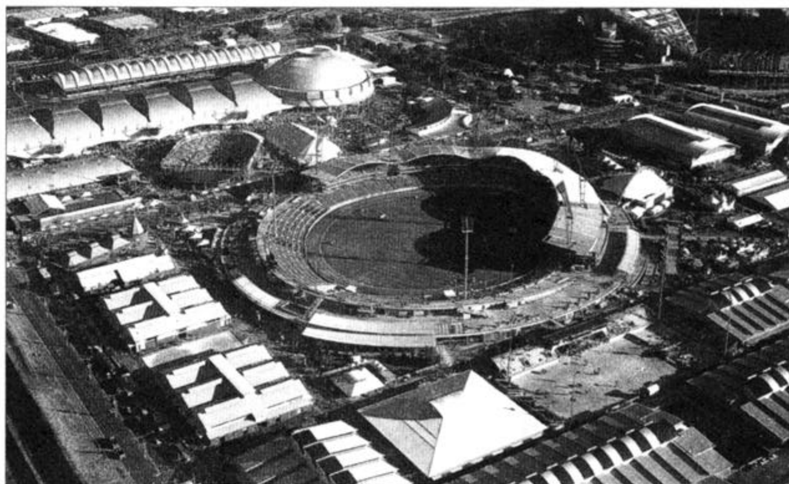
(图4-0-6) 澳大利亚皇家协会(RAS)展馆建筑群及主体育场
