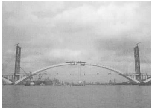
图 0-1 正在合拢中的上海卢浦大桥
