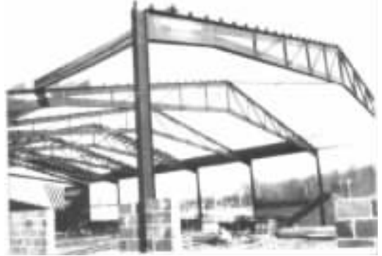
图 1-4 正在建设中的钢结构厂房
