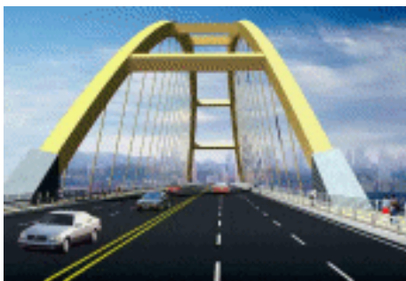
图 1-8 钢管混凝土桥
