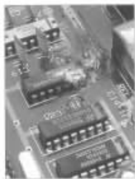
图 18 外观上仅可见一片集成电路芯片损毁,实际该电路板上的全部集成电路芯片均已损坏
