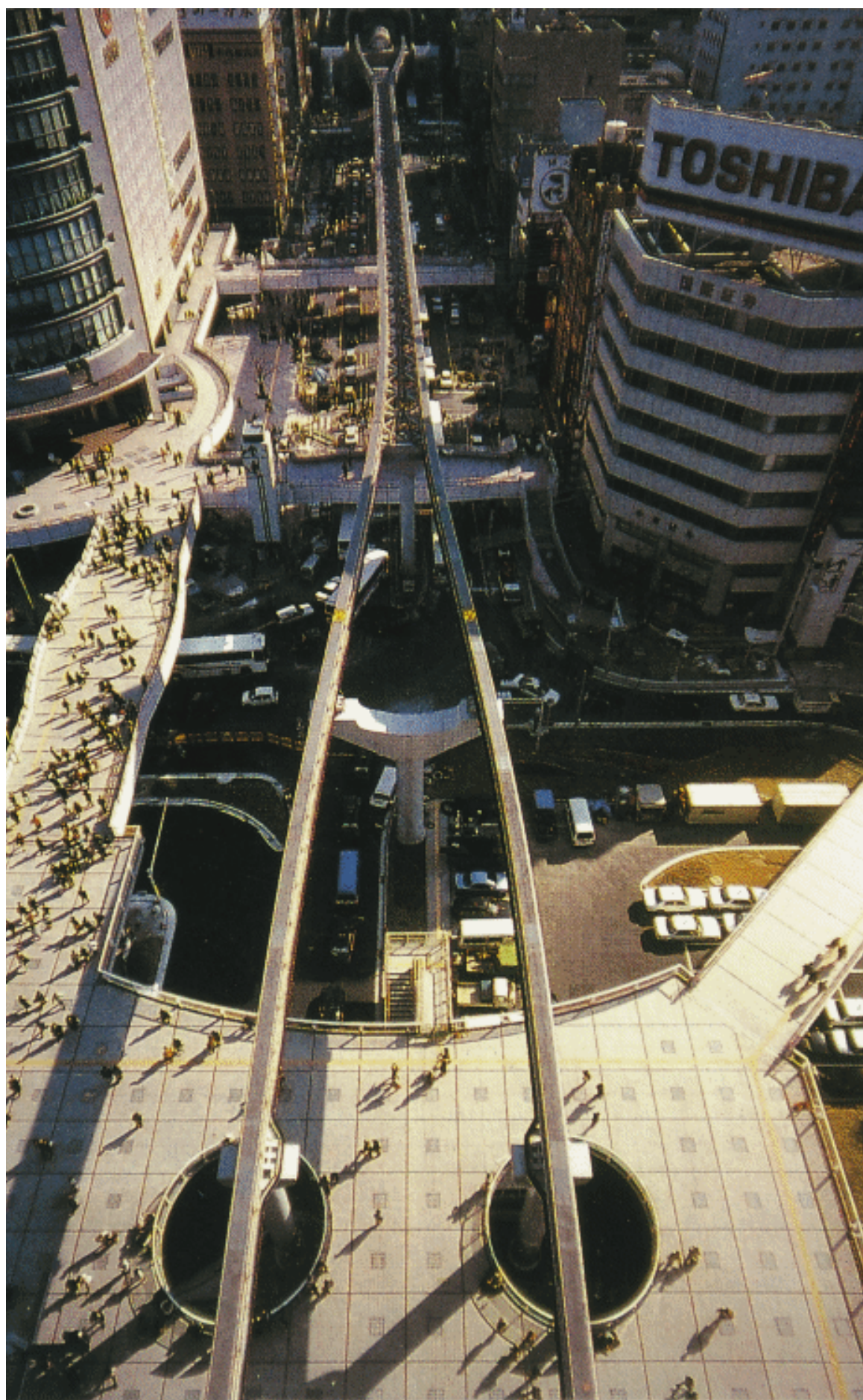
图 1.2 日本北九州火车站前广场
