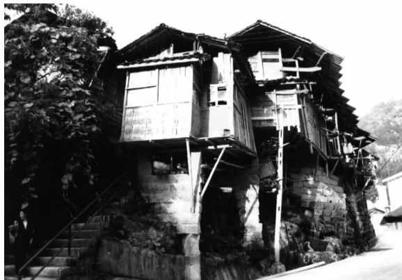
“悬吊吊”的阁楼
