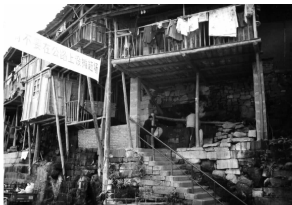
公共道路从干栏柱网中穿过
