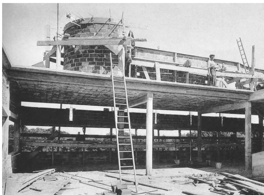
图 4-1 施工中的萨伏伊别墅
