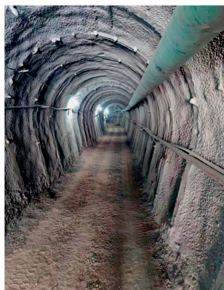
2022年6月30日，西吉县重点水利工程铁家窑水库隧洞建设现场。
