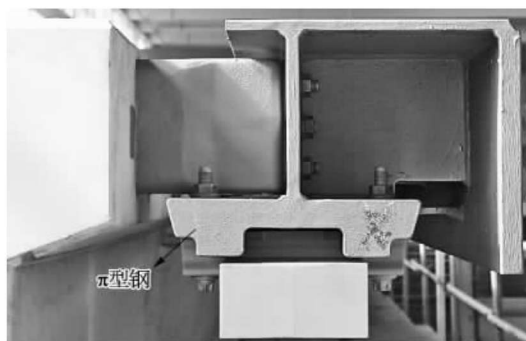
图 1-6 定子铁心在功能件上的位置
