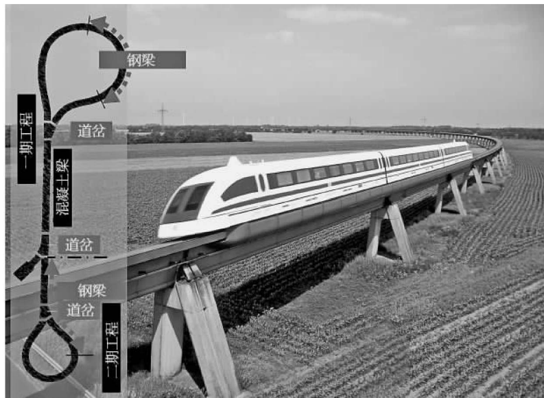
图1-1 德国TVE常导高速磁浮试验线
