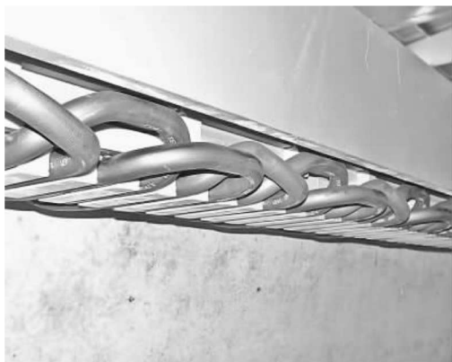
图 1-4 轨道的长定子和线圈
