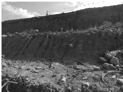
图 3.2 老路基台阶面松散
