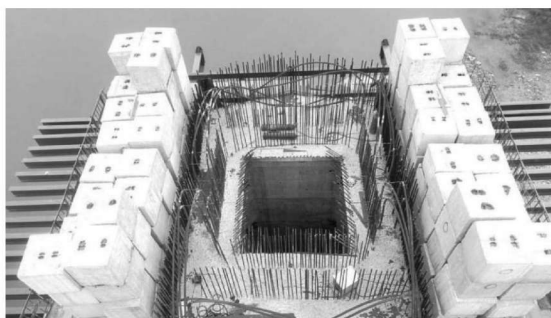
图 4.2 主墩 0 号块托架预压示意图
