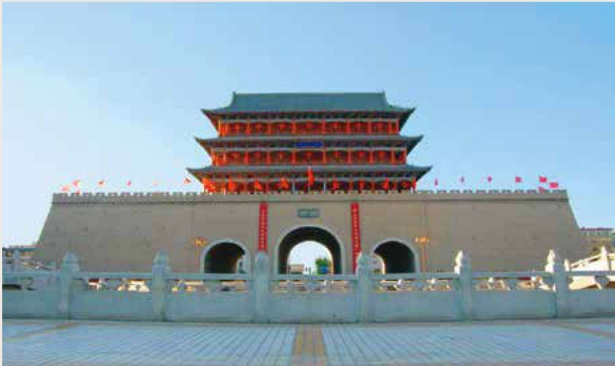
武威市地标性建筑——南城门楼
