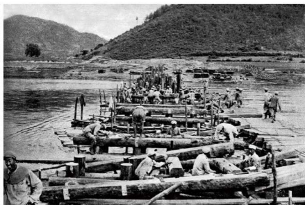
铁道工程总队官兵在冰冷的秃鲁江抢修桥梁，创造性地修建了水下路，可以起到很好的隐蔽作用
