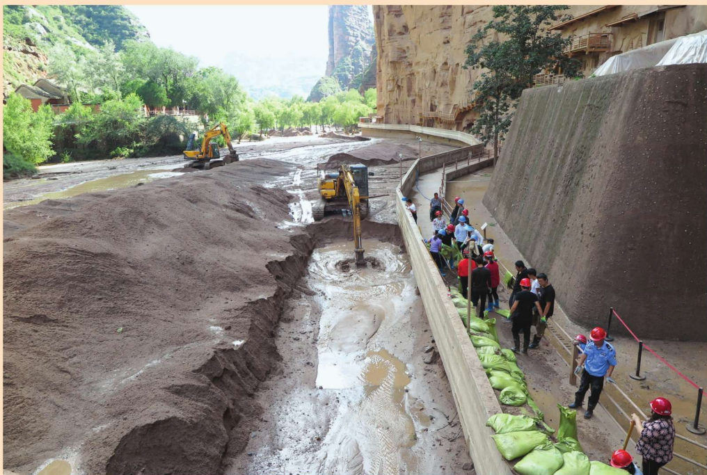
炳灵寺开挖排洪沟，清理泥沙，疏通下游河道
