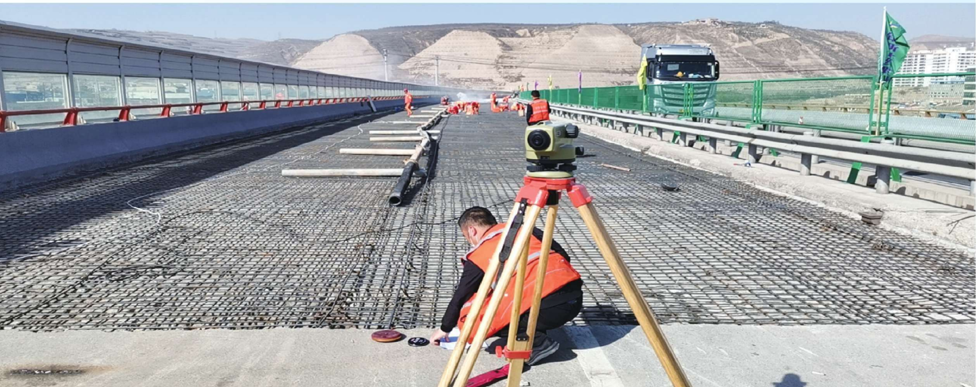
大桥桥面铺装
