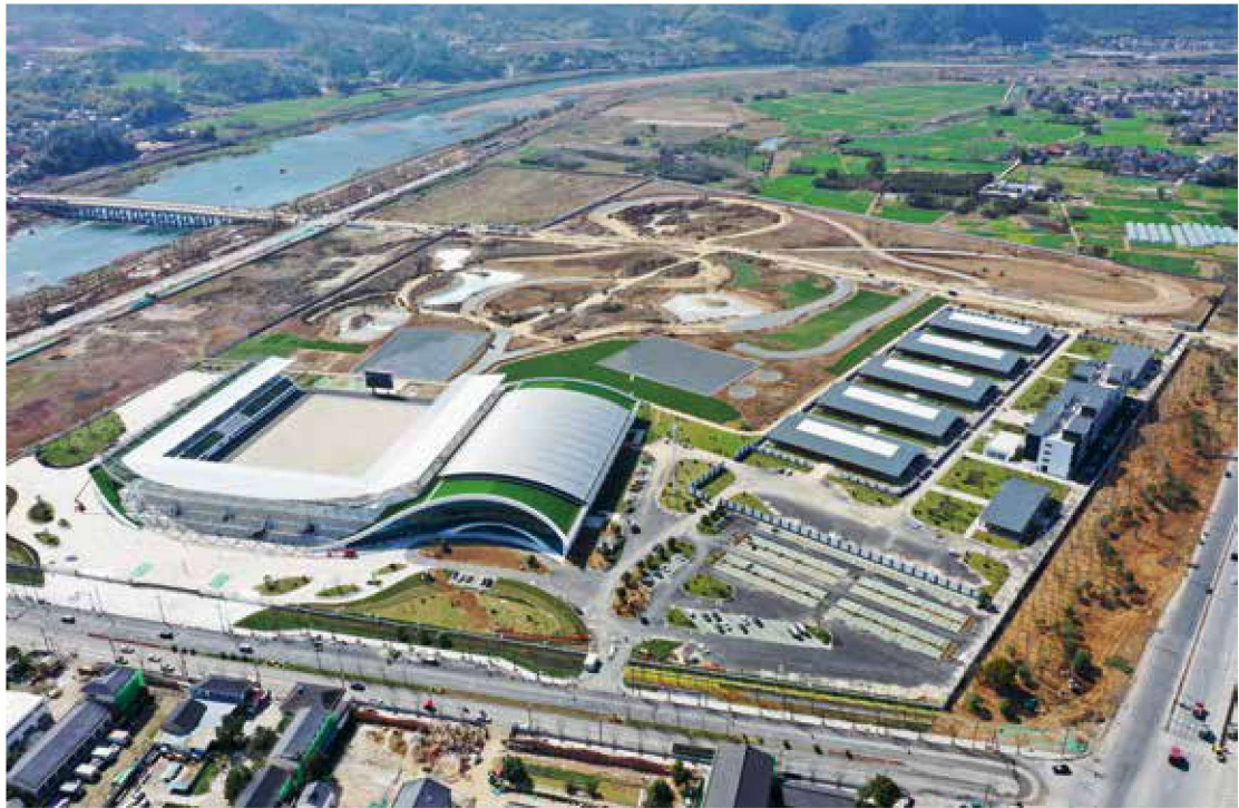
2021年9月28日，桐庐马术中心项目主场馆建设全面完工
