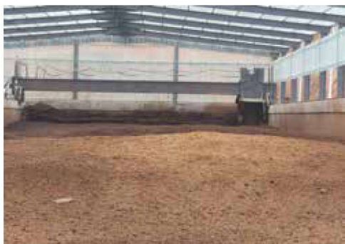
图 1-9 粪便无害化处理区
