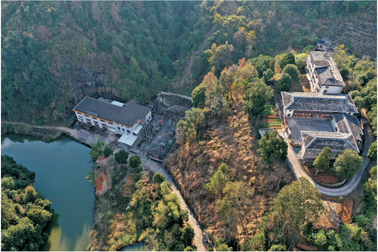
青印溪二级电站
