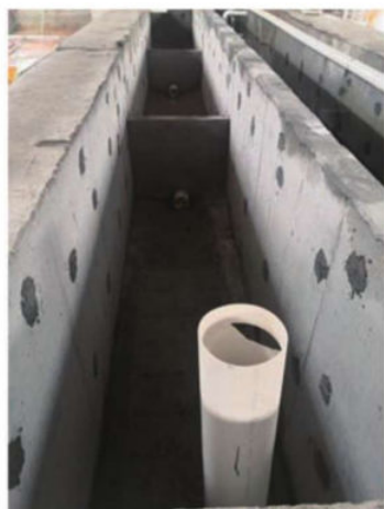
图 2-4 集污池结构实景图
