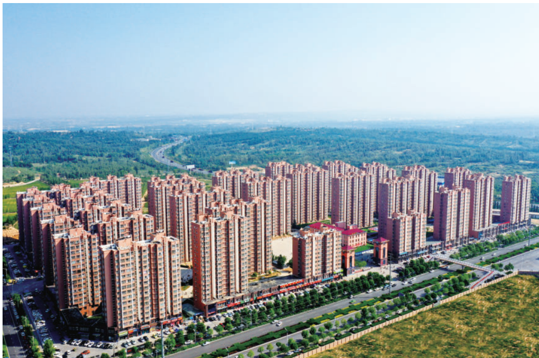
榆林市榆阳区公租房金林小区
