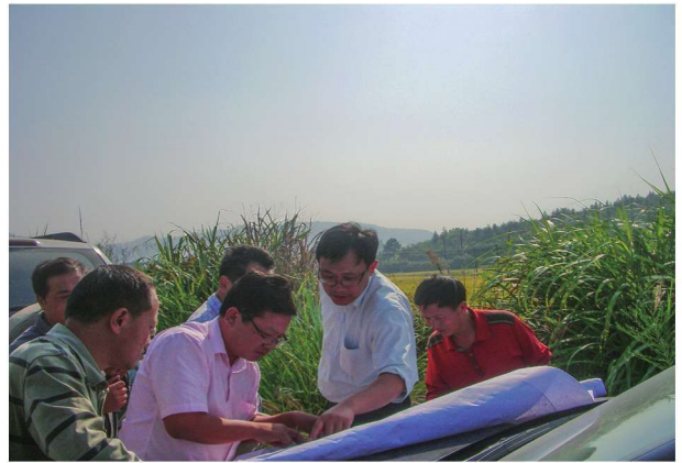
现场踏勘研究高速公路路线方案
