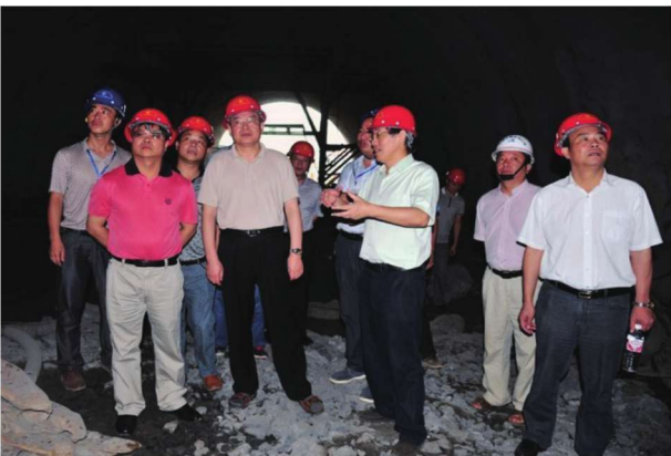
江西省交通运输厅党委书记、厅长朱希视察院设计的隧道工地
