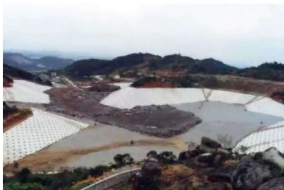
(a) 福建泉州垃圾填埋场
