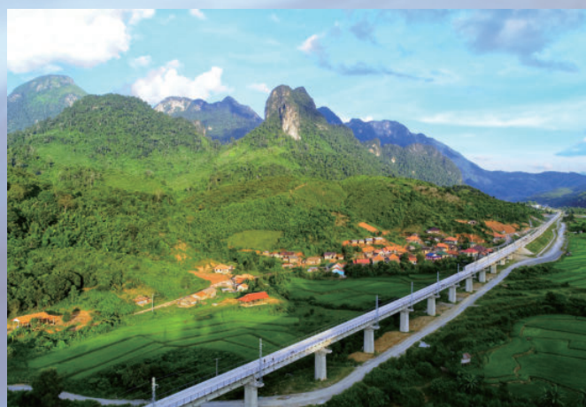
中老铁路楠逢河特大桥，由水电十四局承建
