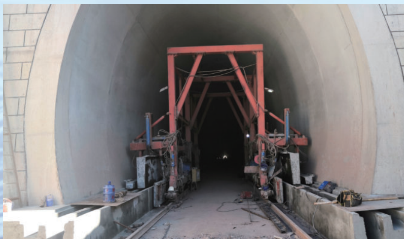
中老铁路V标旺村隧道水沟电缆槽施工，由水电十五局承建
