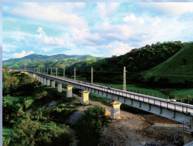
中老铁路IV标楠逢河特大桥，由水电十四局承建
