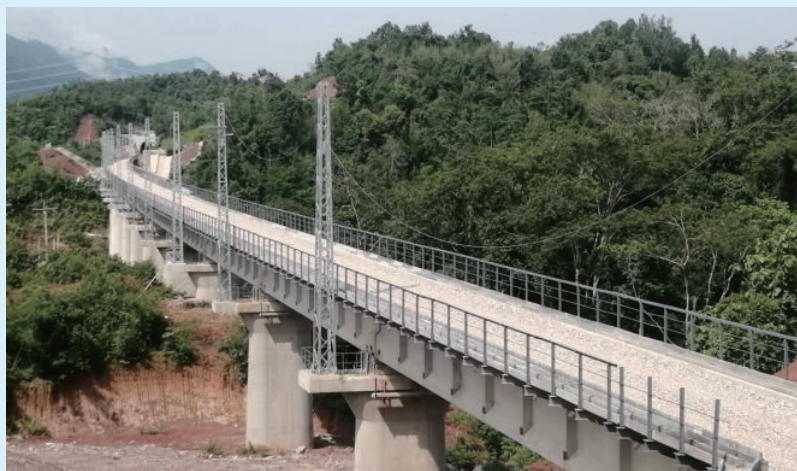
中老铁路V标会发河特大桥，由水电十五局承建
