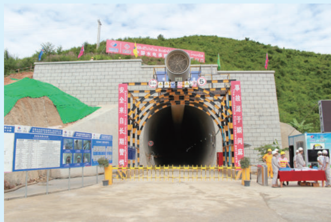
中老铁路IV标那迷2#道出口洞外标准化布置工程，由水电十四局承建
