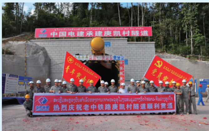
由水电十五局承建的中老铁路V标庚凯村隧道，为全线首座贯通隧道，图为隧道贯通后的庆典现场
