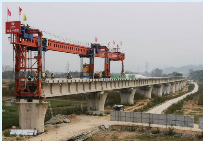
中老铁路V标旺门楠松河特大桥，由水电十四局承建
