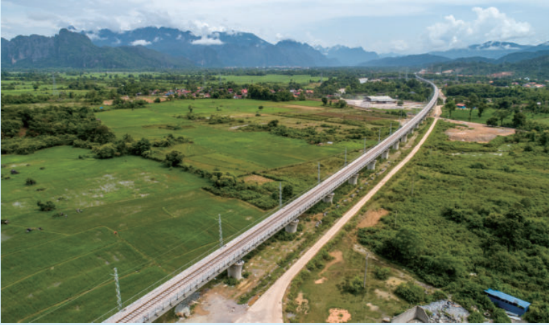
中老铁路V标朋松楠松河特大桥，由中国水利水电第十工程局有限公司（以下简称水电十局）承建
