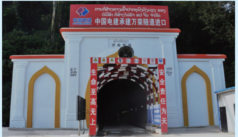
中老铁路V标万荣隧道工程，由水电十局承建
