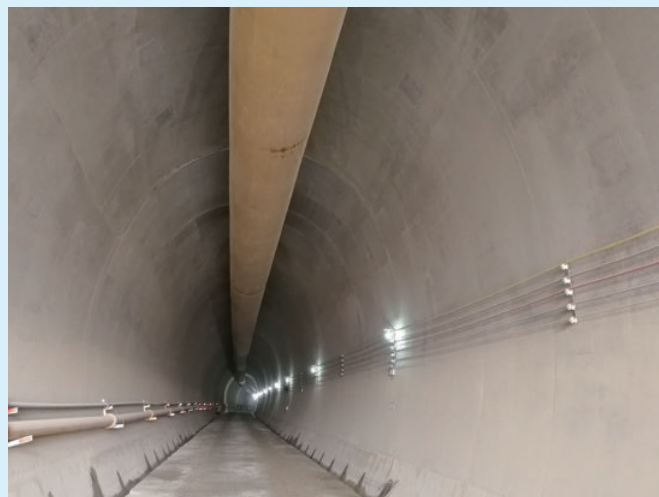
中老铁路IV标那迷2#隧道工程，由水电十四局承建
