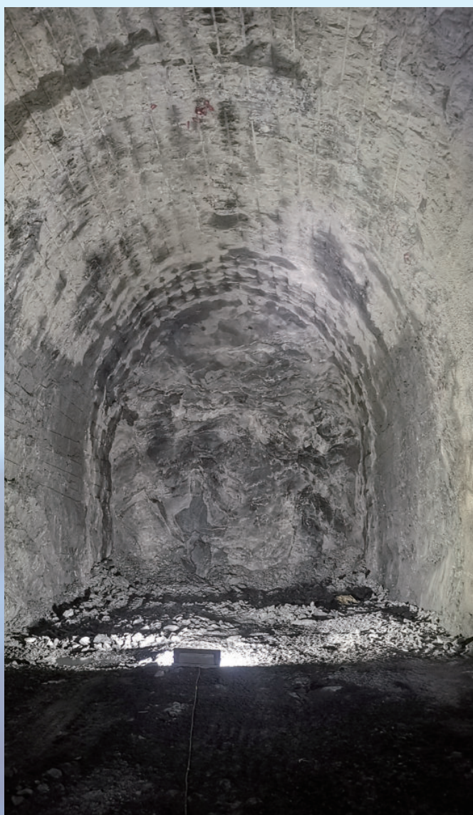
中老铁路IV标森村2#隧道工程，本段由水电十四局承建
