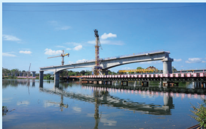
中老铁路V标欣和楠里河特大桥，由水电十五局承建
