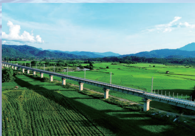
中老铁路孟卡西楠里河特大桥，由水电十四局承建
