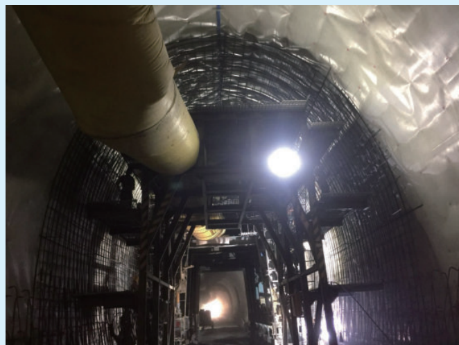
中老铁路IV标森村1#隧道工程，由水电三局承建
