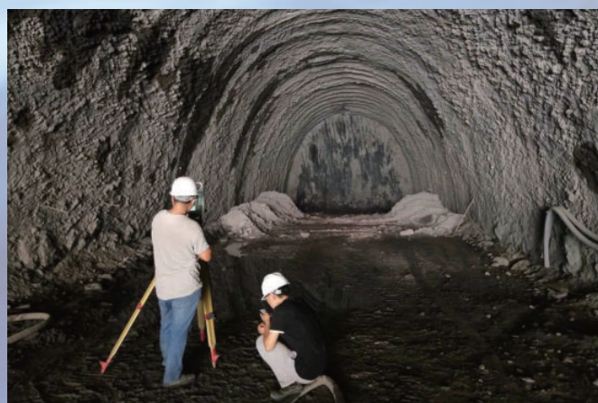
中老铁路IV标沙嫩山1#隧道工程，由水电三局承建
