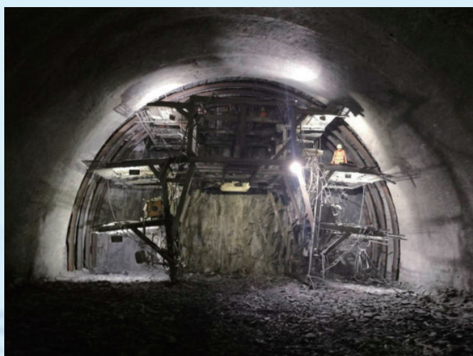
中老铁路IV标森村2#隧道工程，本段由水电三局承建
