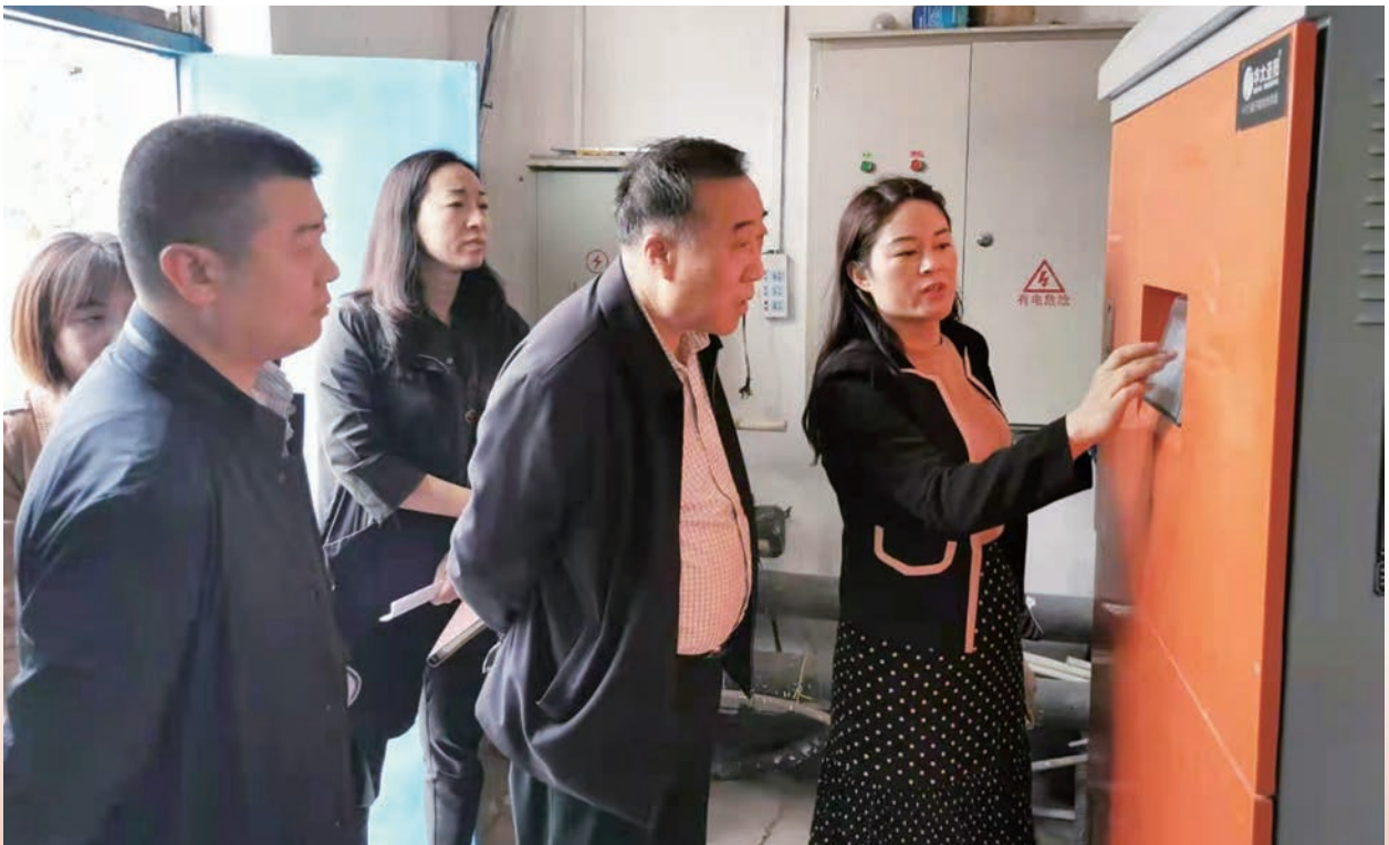
财政厅党组成员、驻厅纪检监察组组长白德东在西夏区调研煤改电项目
