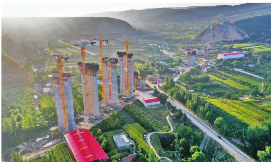
建设中的银昆高速 (G85)彭阳境任湾特大桥 杨巨辉 / 摄
