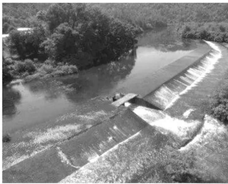
图五 堰体上部一孔中空排沙 (江西泰和槎滩陂)
