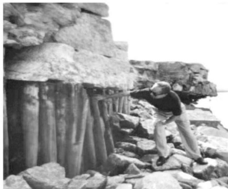
图四 木桩地底部中空 (山东大汶河戴村坝)
