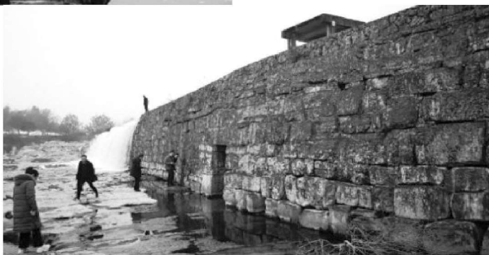
图七 底部中空排沙 (湖北崇阳石枳堰)
