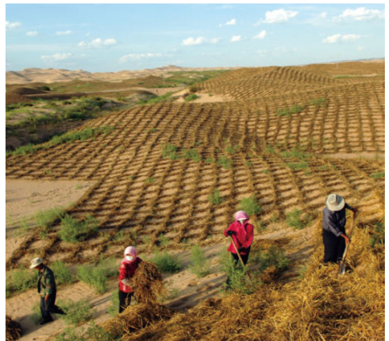
腾格里沙漠防风固沙工程——草方格固沙
