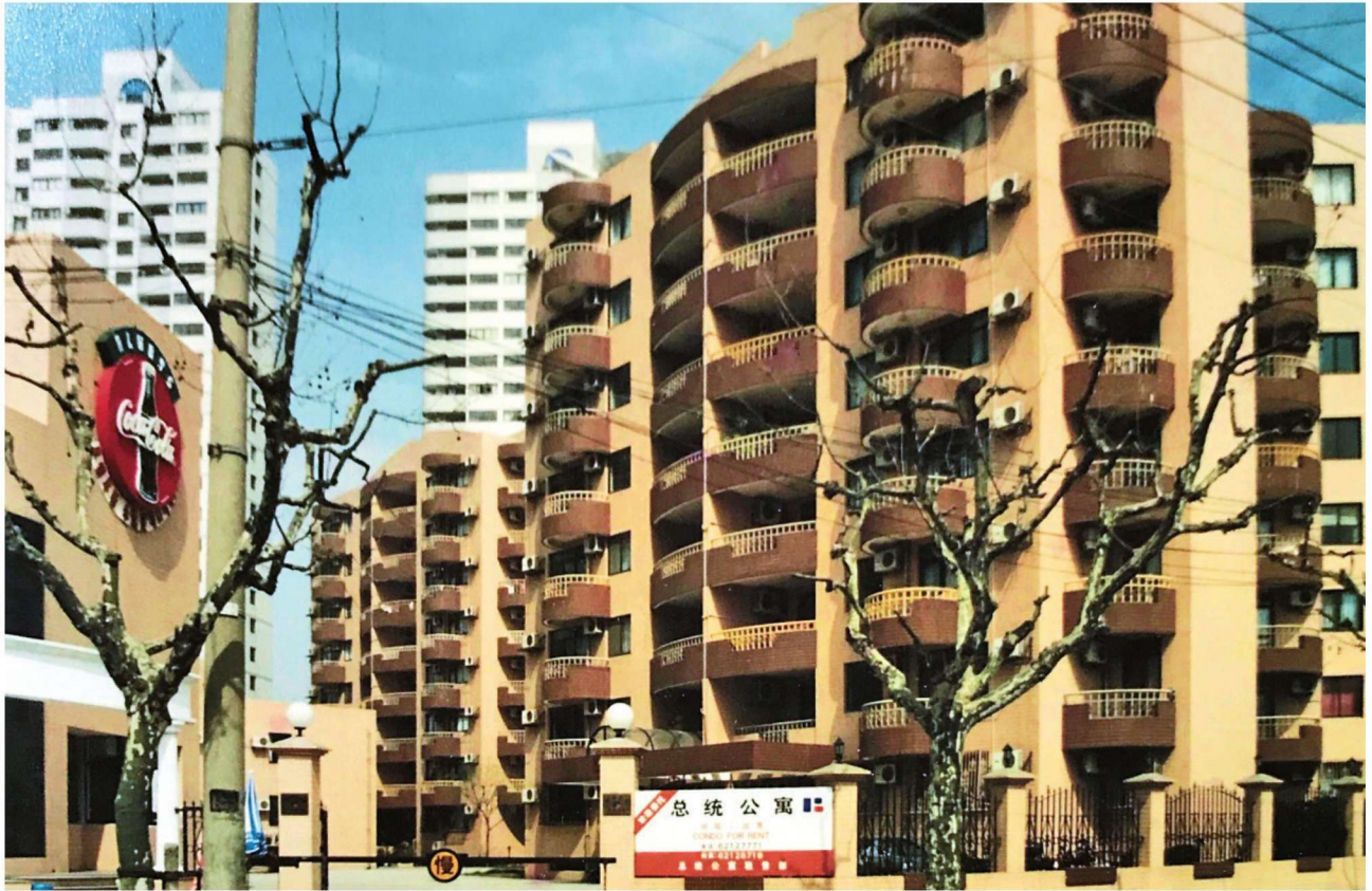
长宁区第一块土地批租建造的项目——总统公寓（华山路 868 弄 1—6 号）
