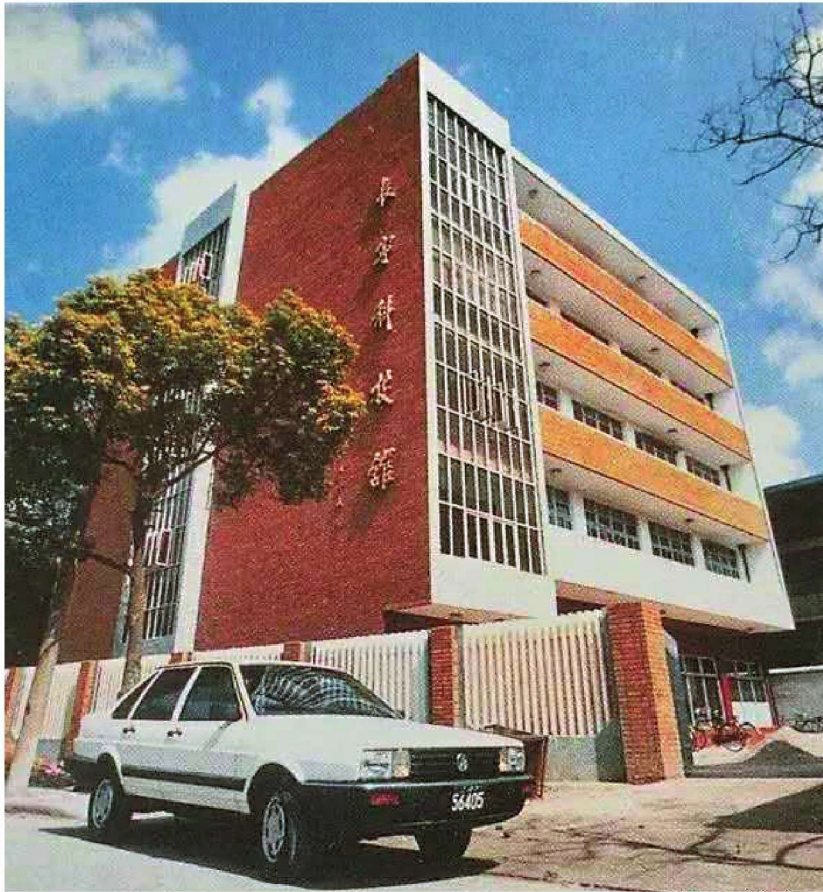
长宁科技馆旧址（安化路 35 号）
