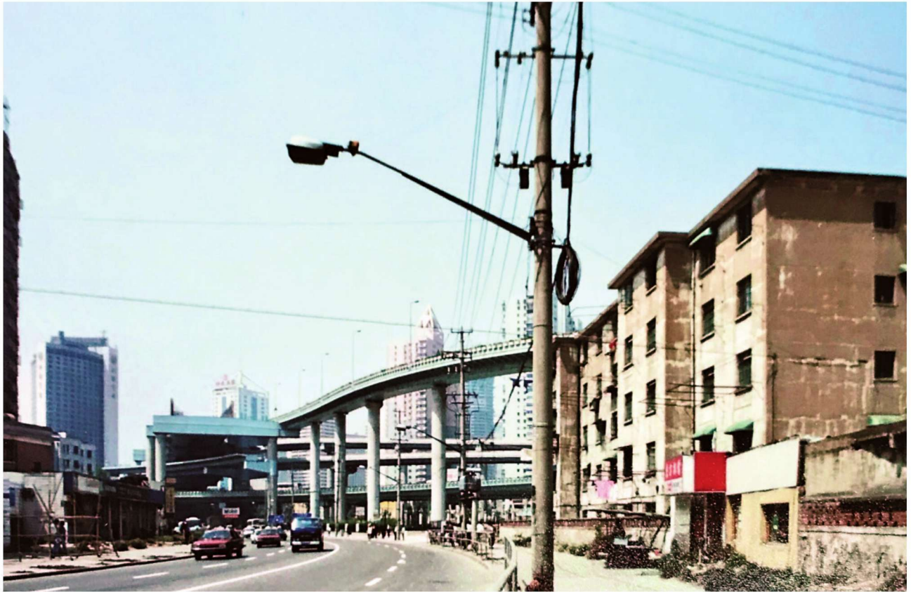
延安高架路（中段）未施工前
