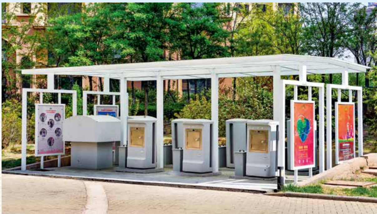
4月30日，中新天津生态城入选全国“无废城市”建设试点。图为气力垃圾运输系统 中新天津生态城管委会 供稿
