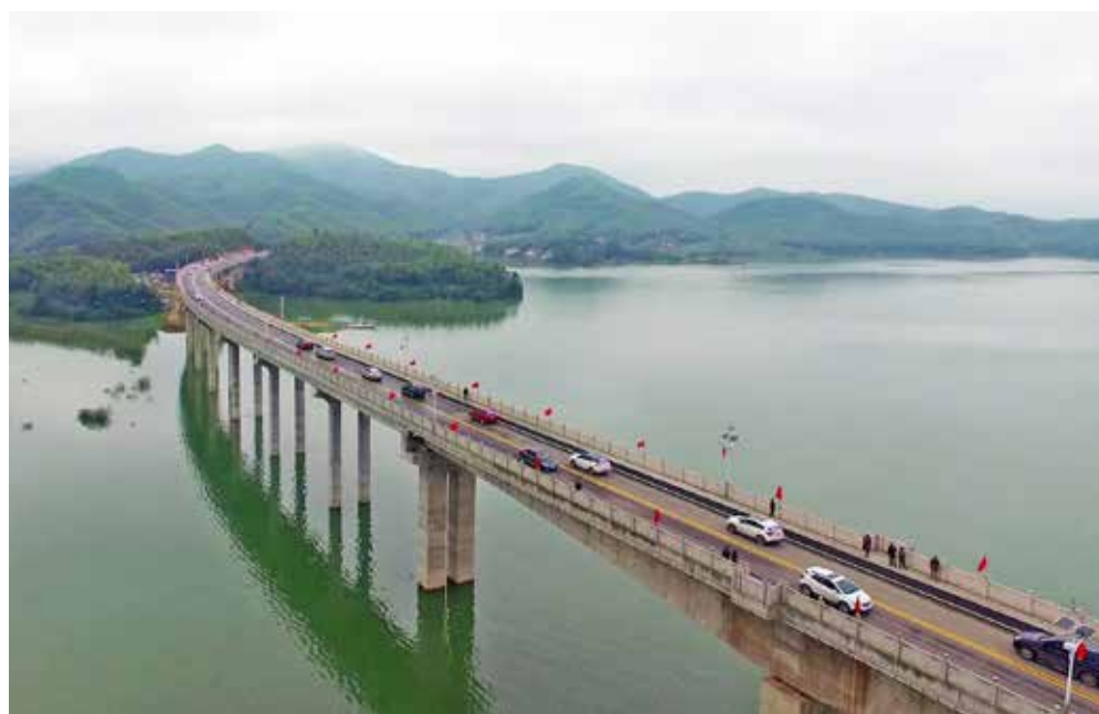
2017年10月6日，赤壁市重点交通扶贫项目工程——芳世湾大桥正式通车
