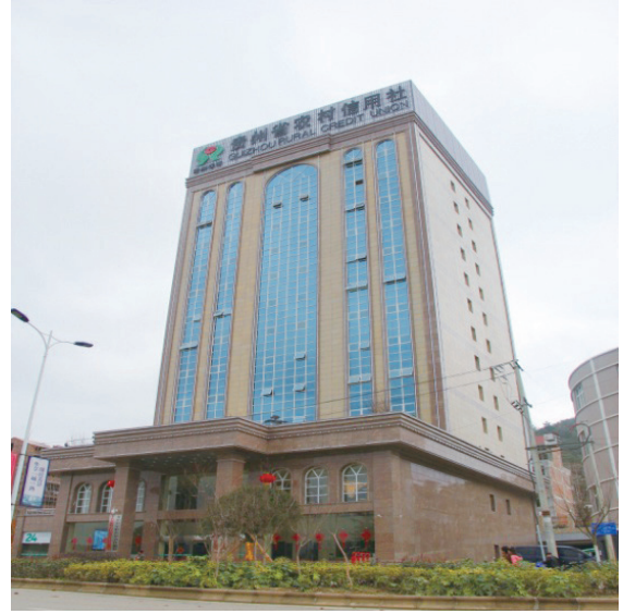
2013年建成的龙里农商银行办公大楼。
