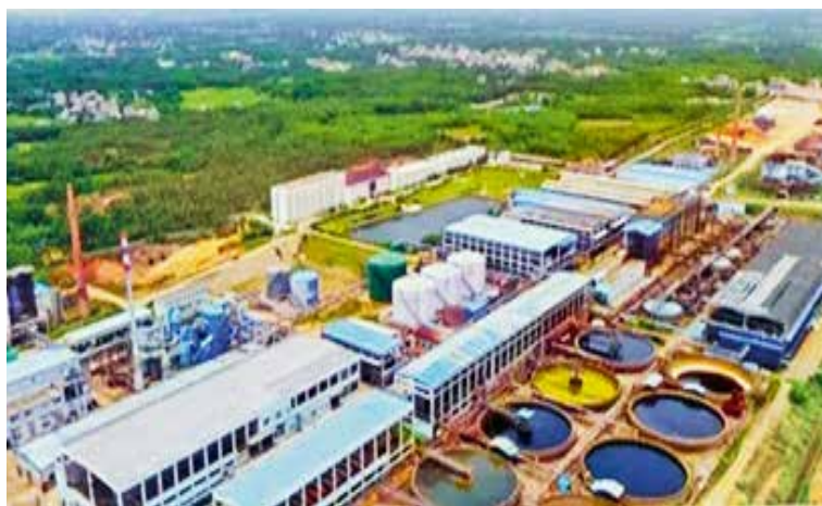
▲ 2014年，博白县深入开展“园区建设攻坚年”活动，加快推进园区建设。图为位于龙港新区龙潭产业园内的广西银亿新材料公司生产厂区
