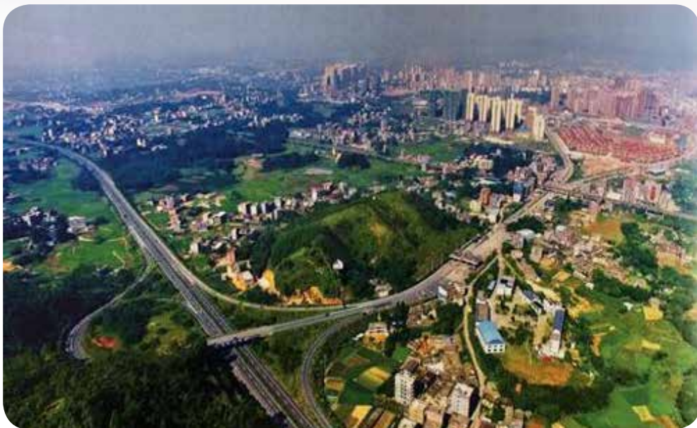
▲ 2014年4月3日，玉林至铁山港高速公路竣工通车，结束了博白县无高速公路的历史。图为玉铁高速公路（博白出口）
