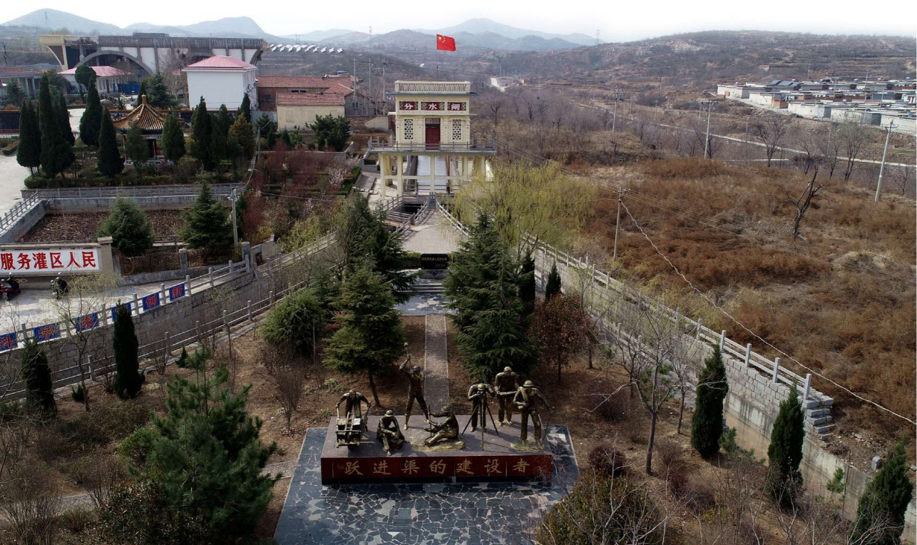
安阳县跃进渠分水闸
