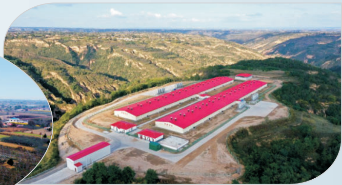
庆阳正欣元西峰区齐楼村生猪育肥场
