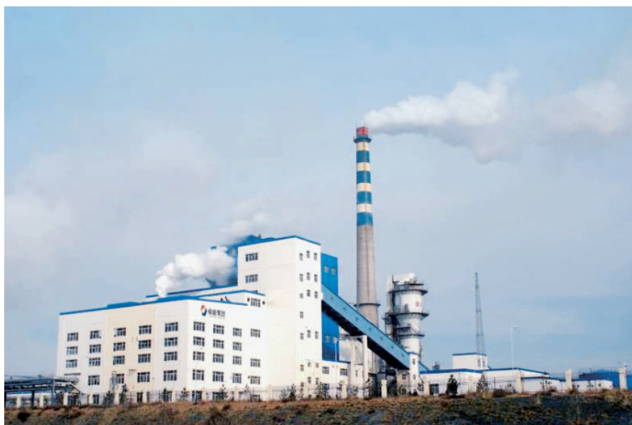
榆佳经济技术开发区榆能佳县盐化120万吨真空制盐项目（曹元忠 摄于2019年）
