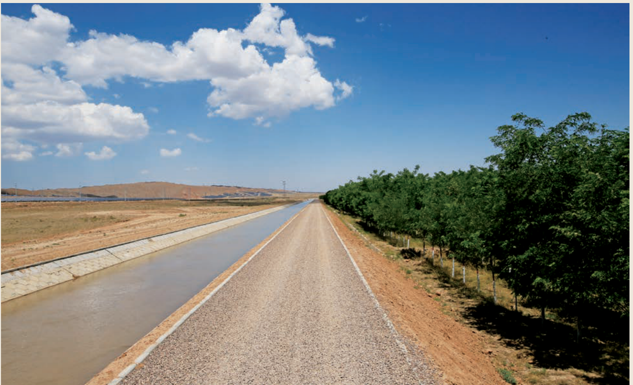
固海扬水五千渠（固海扬水管理处提供）
