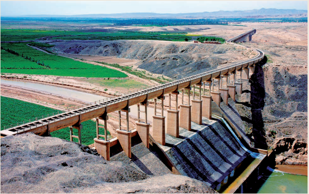
固海扬水工程长山头大渡槽（固海扬水管理处提供）
