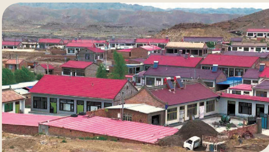
喊叫水乡上流水村农民新居（中宁网提供）
