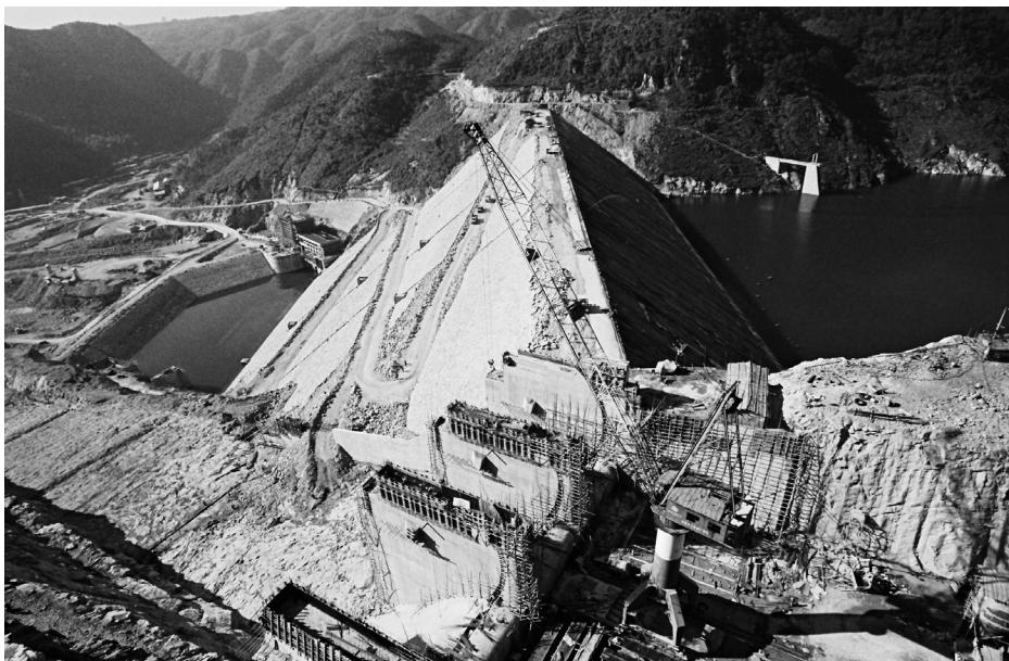
白溪水库建设时期
