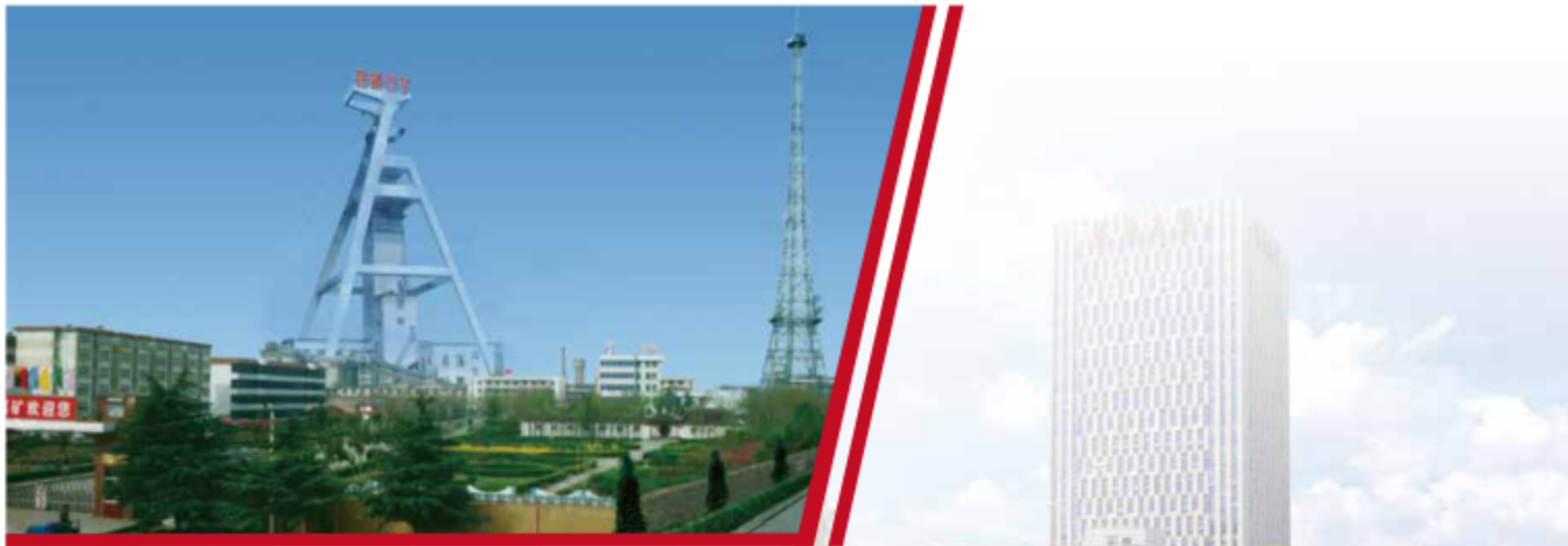
张集煤矿外景
