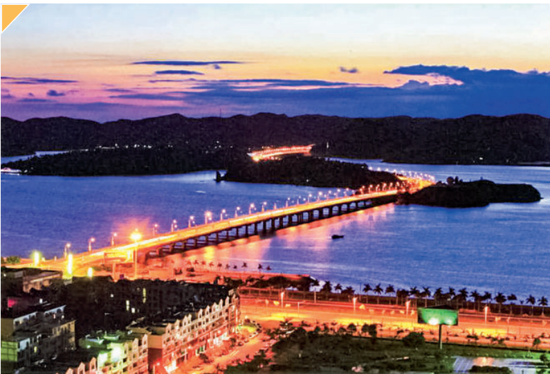
防城港市西湾跨海大桥于2001年开工建设,2003年10月建成通车。大桥总长1570米,宽24米,为双向四车道。图为大桥夜景
