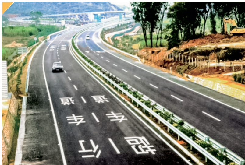
南友(南宁—友谊关)高速公路与越南1号公路相接,为中国与东盟实现陆路通的第一条高速公路,也是广西第一条沥青混凝土路面高速公路,全长179.2公里,2002年12月25日开工,2005年12月8日建成通车
