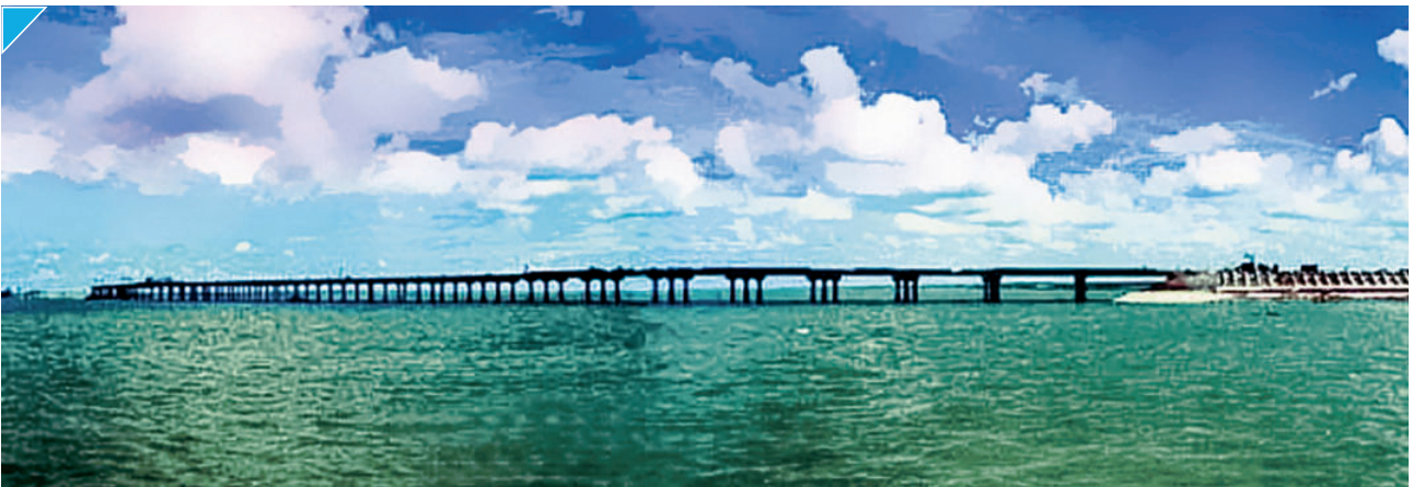
1999年11月动工,2001年12月建成的北海铁山港跨海特大桥全长2998.02米,其中20米跨的56孔,30米跨的54孔,50米跨的3孔
