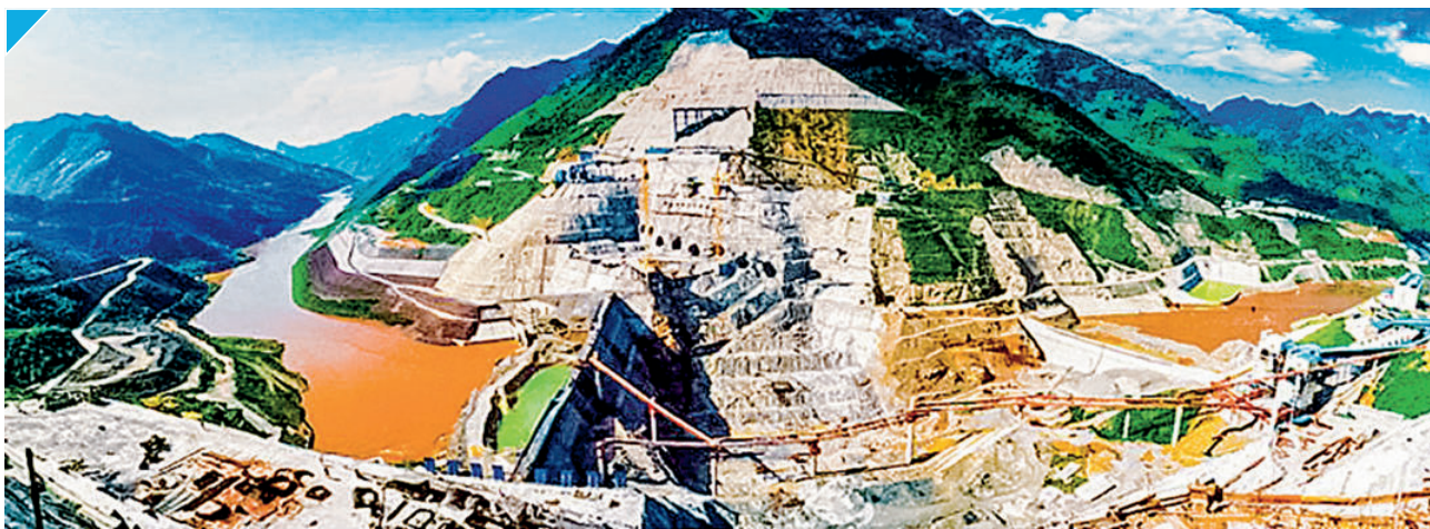
龙滩水电站为红水河梯级开发中的龙头骨干控制性工程，位于天峨县境内红水河的龙滩河段。工程于2001年7月1日开工，1—3号机组分别于2007年5月21日、7月20日和10月31日投入试运行。该电站装机7台，总容量420万千瓦，是当时国内仅次于三峡的巨型水电站。图为龙滩水电站施工中的场景
