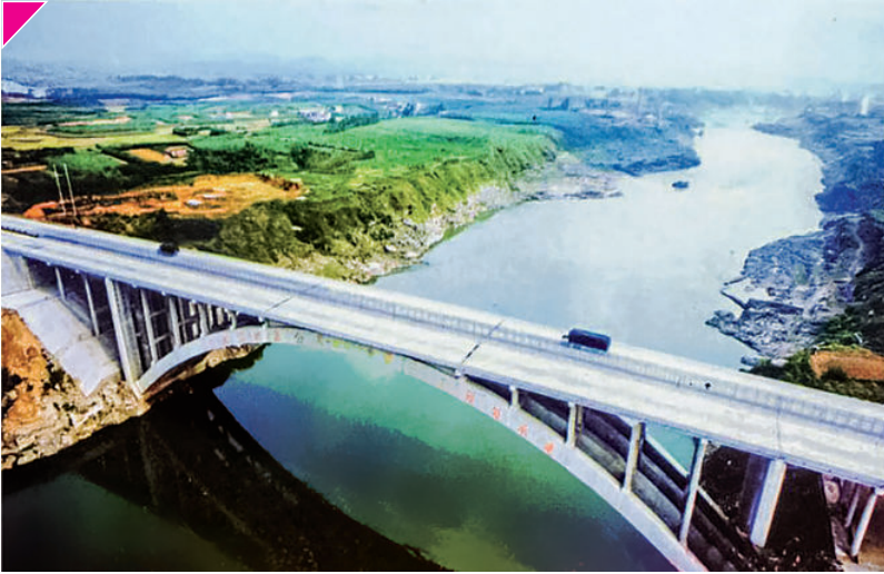
1999年9月建成的来宾磨东大桥,位于柳州—南宁高速公路上,主跨180米,开创了钢筋混凝土箱肋拱桥大跨度、大重量、多段吊装之先河,成为中国钢筋混凝土箱肋拱桥的重要里程碑
