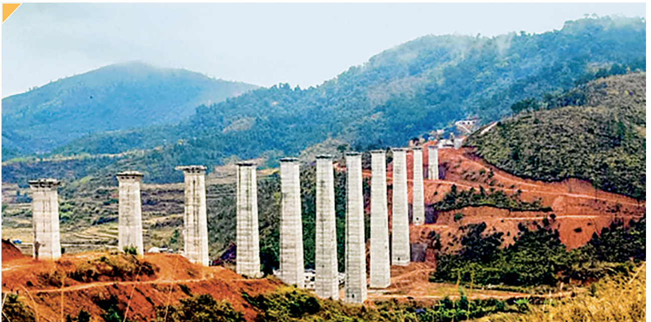
建设中的洛湛铁路第一高墩桥——良梧特大桥工地现场
