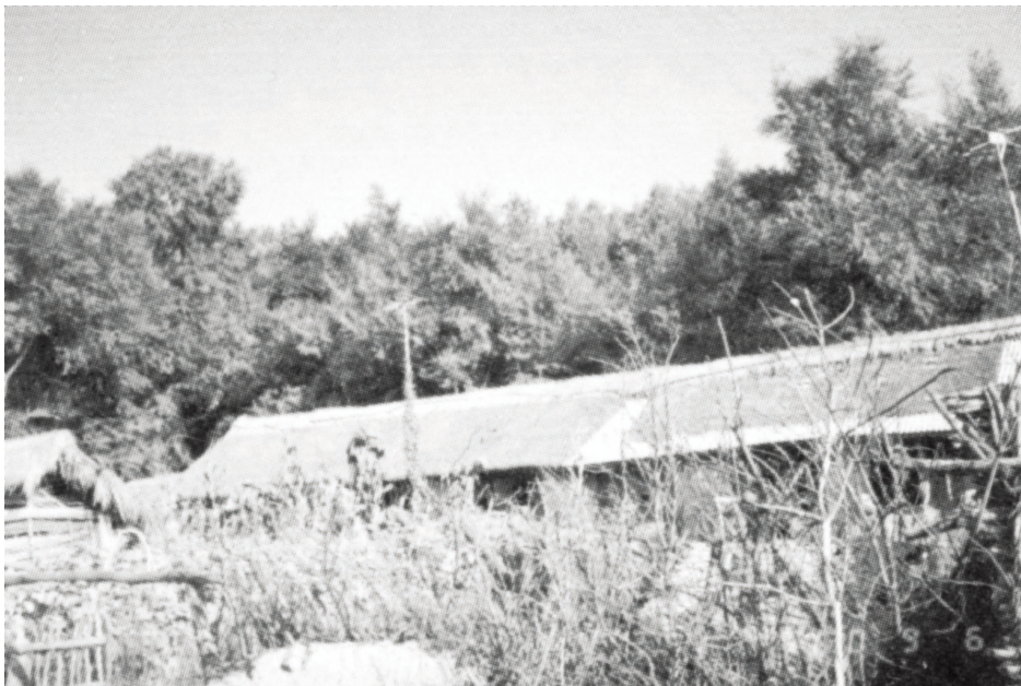
中共东丰县横道河支部旧址
