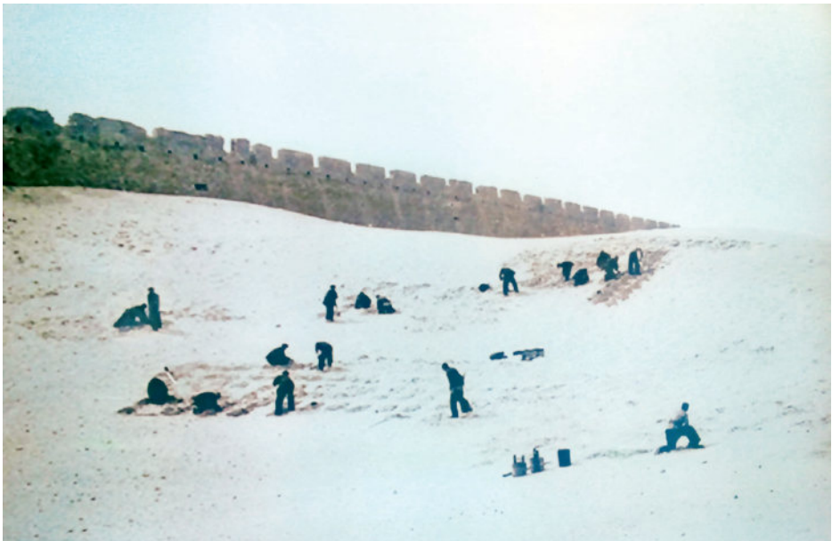
风沙湮没榆林东城墙
