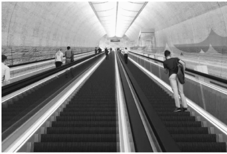
42 m 长城八达岭高铁站扶梯（西奥）
