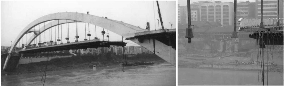
图 1-1-8 宜宾小南门大桥垮塌事故
