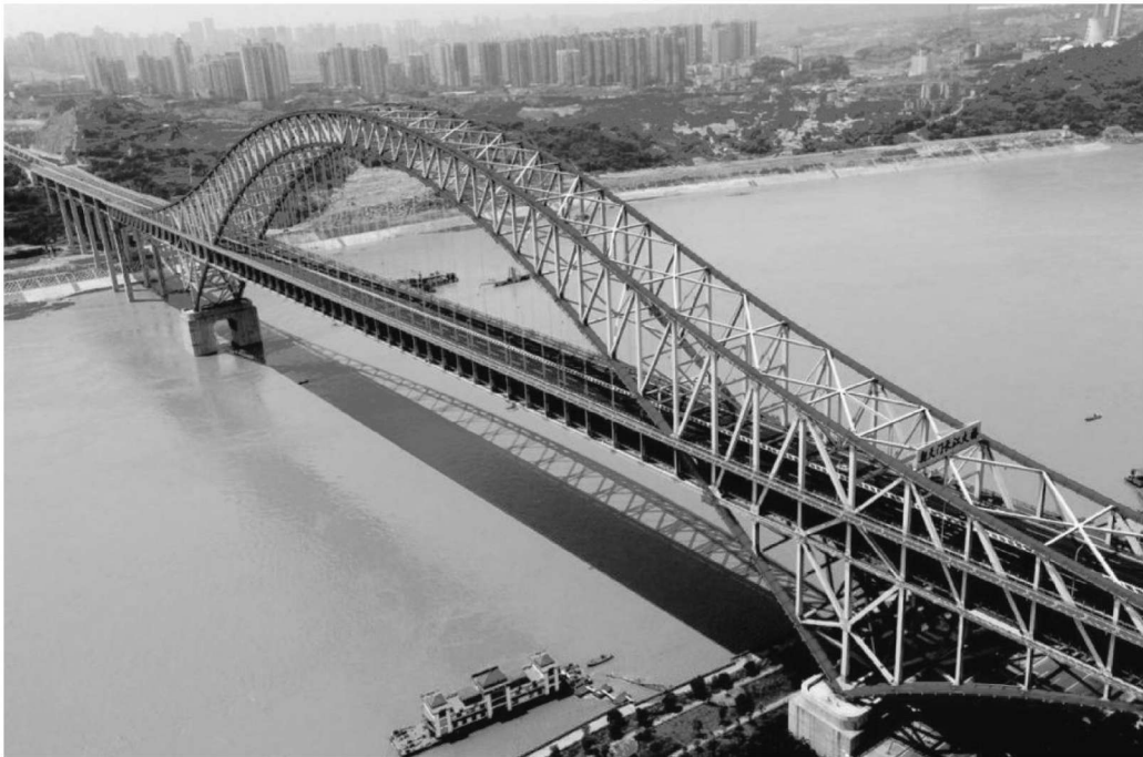
图 1-1-3 重庆朝天门长江大桥
