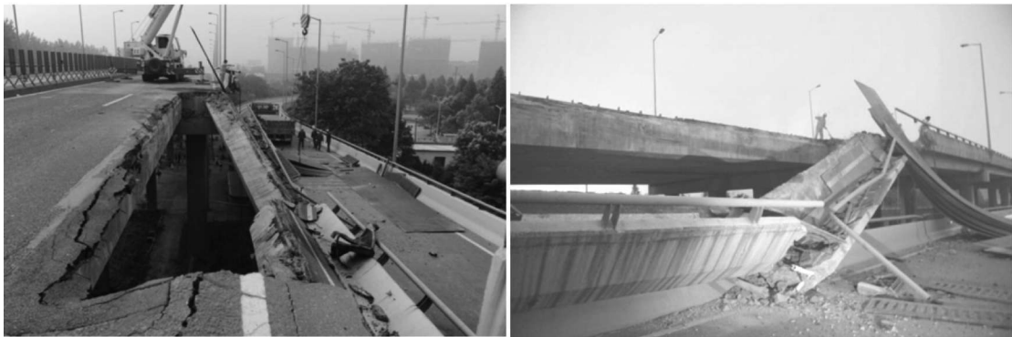
图 1-1-9 杭州钱塘江三桥垮塌现场
