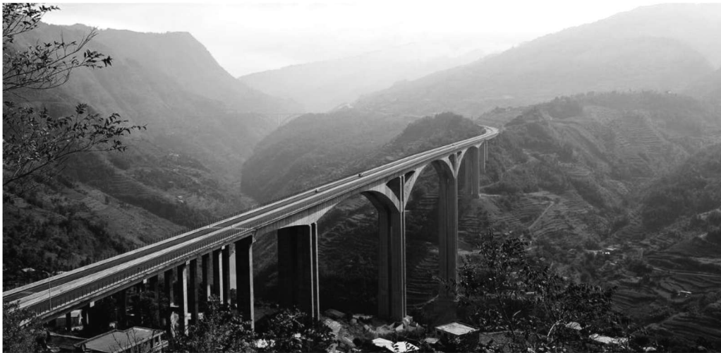
图 1-1-2 贵州省水盘高速公路北盘江特大桥
