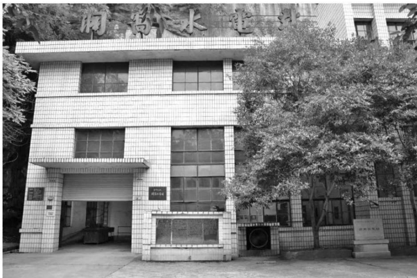
图 1-5 1921 年筹建的洞窝水电站(摄于 2020 年)
