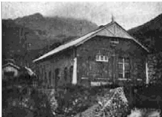
图1-3 1905年建成的龟山发电厂
