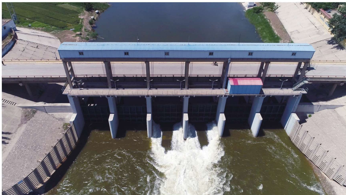
◎ 献县节制闸（献县融媒体提供）
